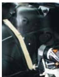
Brtvljenje spoja prskanjem
