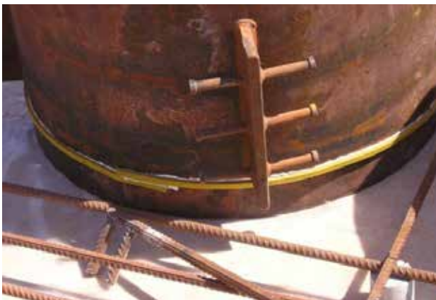
Prelaz čelik/beton
