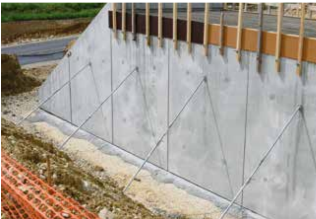
Prefabrikovani betonski elementi
