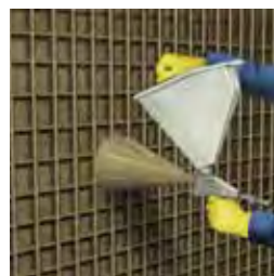
Nanošenje sika Mono Top 910 na očišćenu armaturu kao zaštitu od korozije
