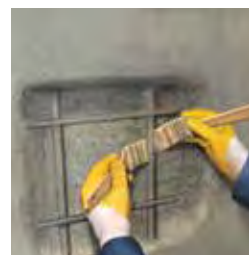
Nanošenje Sika Mono Top 910 na beton kao veza stari-novi beton
