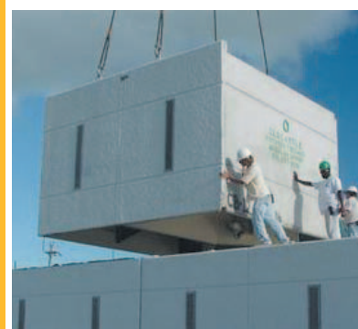
Kraća proizvodnja betonskih elemenata
