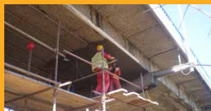
SANACIJA I ZAŠTITA
