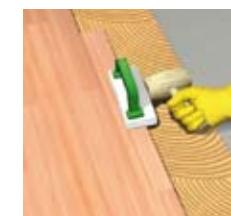
Drveni elementi mogu se uglađivati čekićem ili drvenim blokom.
