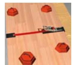
Kod ugradnje masivnog drva preporuča se korištenje trake za privremeno fiksiranje kako bi fuge bile zatvorene, koristiti i dodatni teret - uteg dok ljepilo ne veže.
