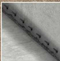
Curenje konstruk- tivnih spojeva
