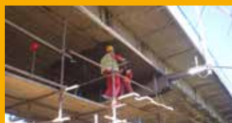
SANACIJA I ZAŠTITA
