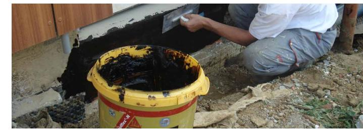
Hidroizolacijski premazi na bazi bitumena su jednostavni za ugradnju. Dodatna mogućnost kod ugradnje je u tome što se na njih direktno može lijepiti toplinska zaštita.
