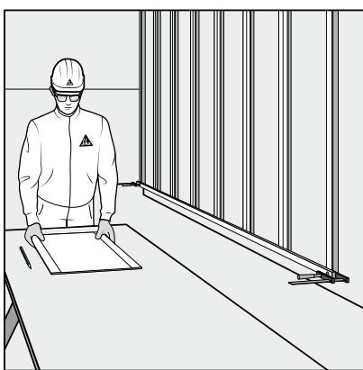
Površina koja se spaja mora biti čista, suha i bez masnoća. Zbrusiti brusnim papirom (zrno 80) na panelu i podkonstrukciji kada se to preporučuje za određeni sistem.
