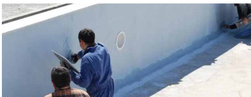
Nanošenje na zidovima bazena.
