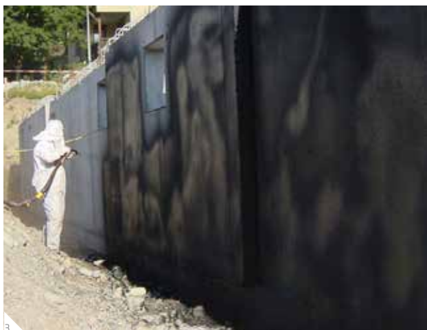
3 Bitumenski premazi i membrane
