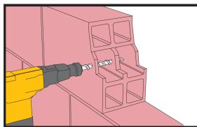
Izbušiti rupu električnom bušilicom do potrebnog prečnika i dubine. Prečnik rupe mora biti u skladu sveličinom ankera i perforiranih tipli.
