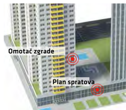
VIŠENAMJENSKA ZGRADA (kombinacija komercijalne i stambene zgrade)
